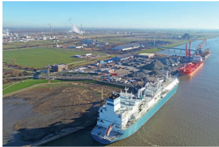
Schwimmendes LNG-Terminal: «Høegh Gannet» im Elbehafen. © Brunsbüttel Ports GmbH
