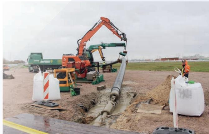
500-mm-Schutzrohr des Dükers kurz vor dem Einzug in das Bohrloch
