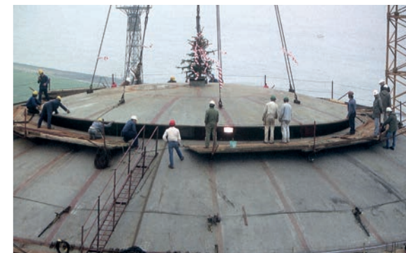
Oben: Das Kernkraftwerk Brokdorf am Abend. Unten links: Das Reaktorgebäude in der Bauphase (1984). Von außen nach innen: Reaktorgebäude, Containment und Splitterschutz, Installationsplatz und Reaktordruckbehälter. Unten rechts: Verschluss des Containments. © Kernkraftwerk Brokdorf
