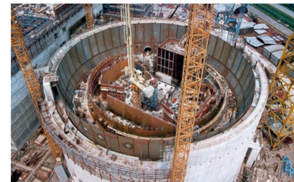
Oben: Das Kernkraftwerk Brokdorf am Abend. Unten links: Das Reaktorgebäude in der Bauphase (1984). Von außen nach innen: Reaktorgebäude, Containment und Splitterschutz, Installationsplatz und Reaktordruckbehälter. Unten rechts: Verschluss des Containments. © Kernkraftwerk Brokdorf
