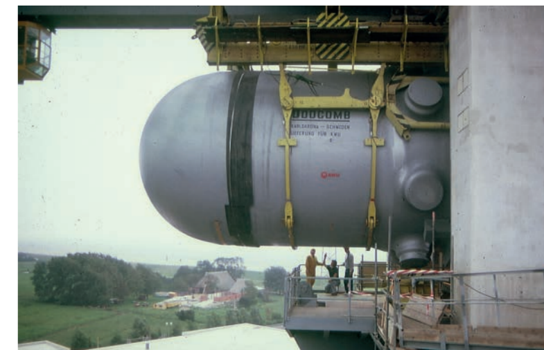
Anlieferung des Reaktordruckbehälters (1985). © Kernkraftwerk Brokdorf
