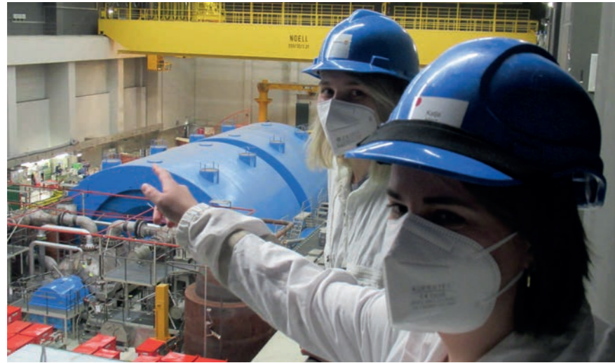
Begleiten den Abbau des Kernkraftwerks: Katja Hinz (vorne) und Antje Poppe. © Kernkraftwerk Brunsbüttel GmbH & Co. oHG
